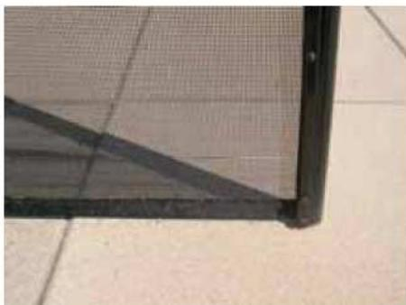
Figure 6. La tige inox doit être complètement enfoncée dans le fourreau d'ancrage (loquet de sécurité **côté bassin**)
